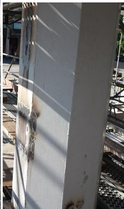
**Bau von Hohlprofilen mit Brandschutzbeschichtung**
